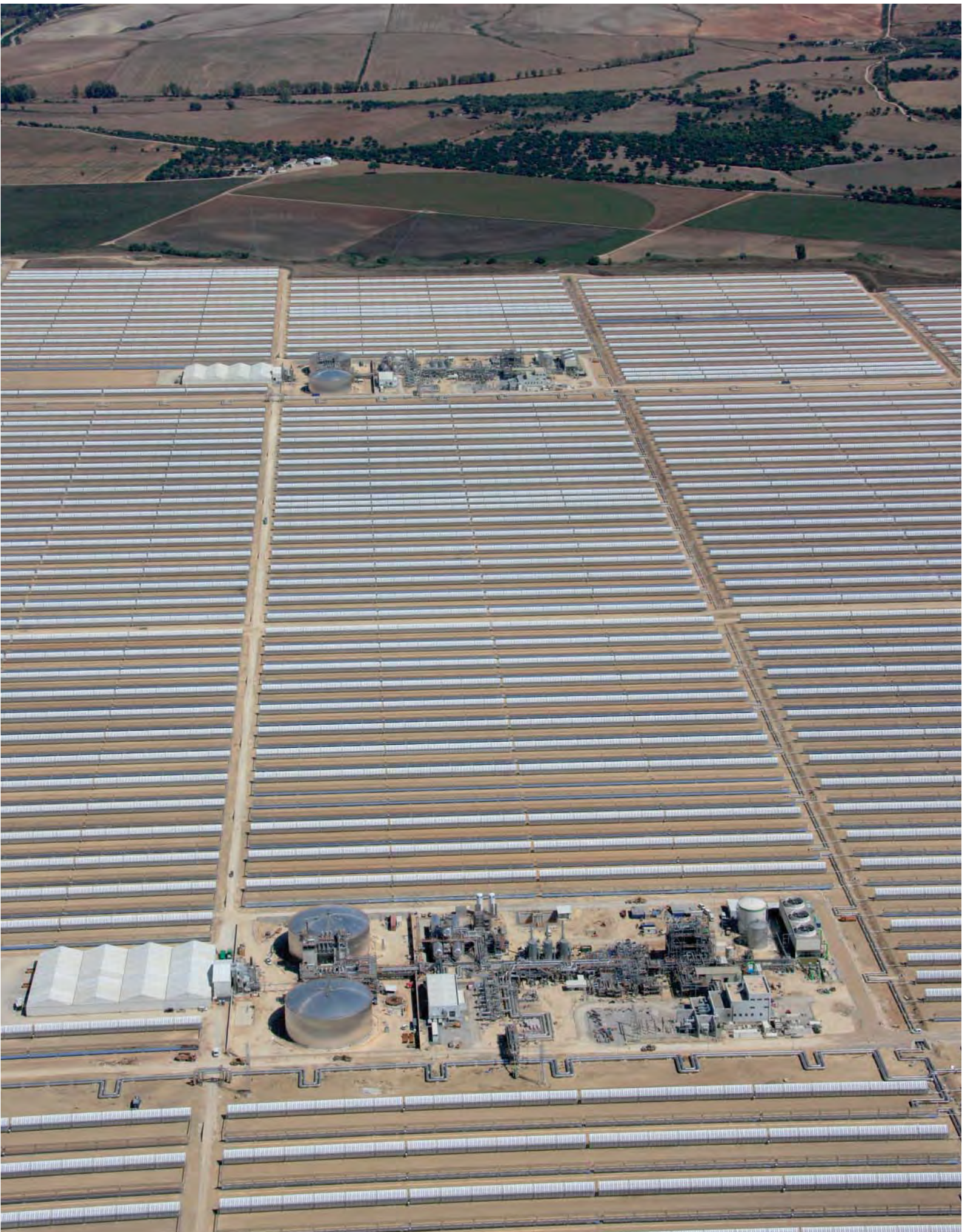
Plantas solares termoeléctricas Valle 1 y Valle 2, Cádiz (España) / Valle 1 and Valle 2 thermosolar power plants, Cádiz (Spain).
