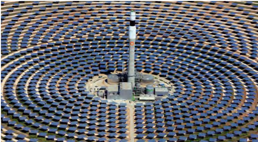
Planta Gemasolar, Sevilla (España) / Gemasolar plant, Seville (Spain).
