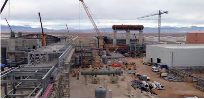
Planta termosolar NOOR I, en construcción (Marruecos). NOOR I solar thermal plant, under construction (Morocco).
