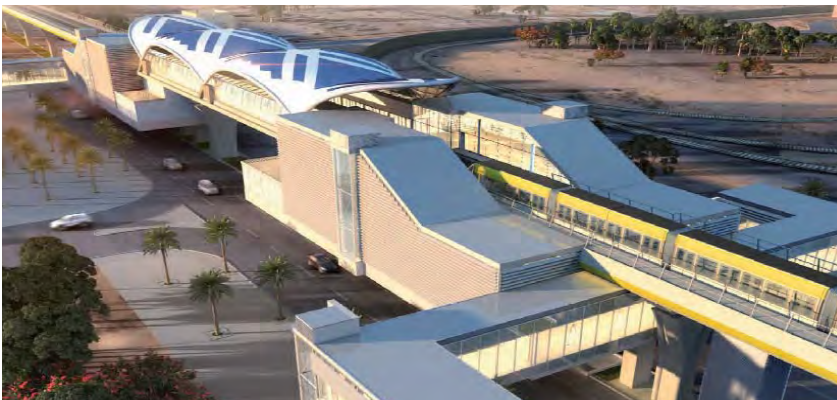
Metro de Riad (Arabia Saudí) / Riyadh metro (Saudi Arabia).
