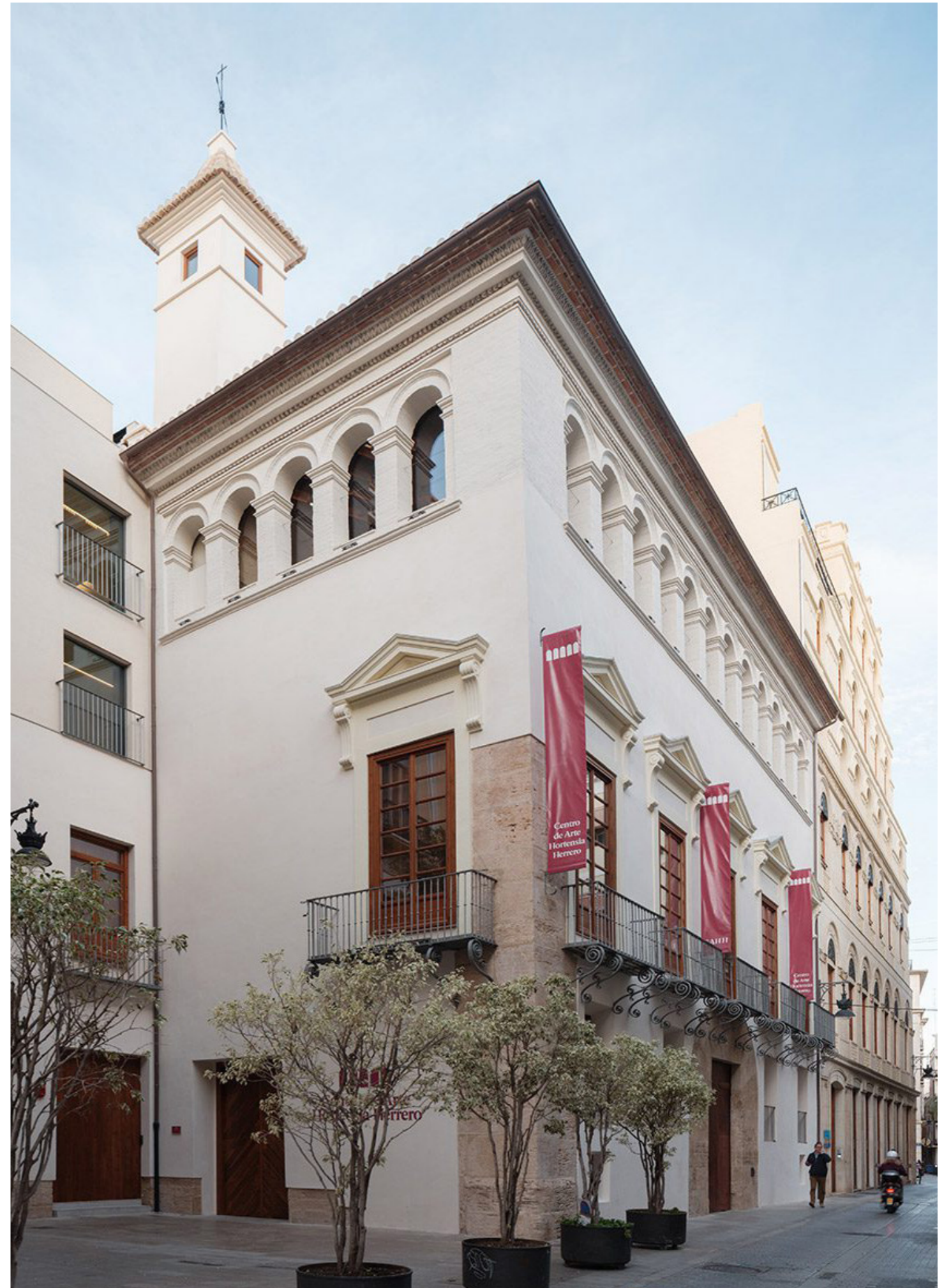
Rehabilitación del Palacio de Valeriola. Nuevo Centro de Arte Hortensia Herrero. Proyecto de ERRE.
