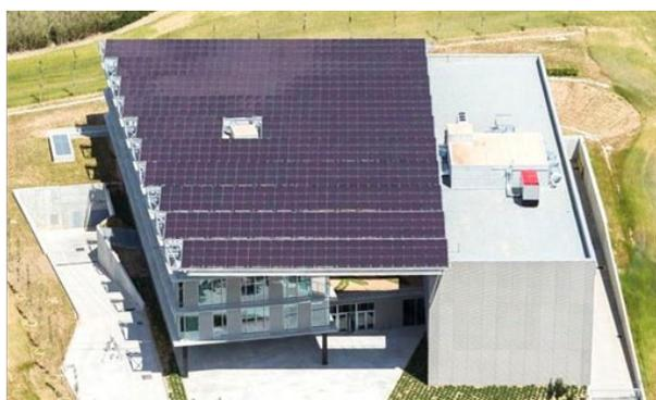
Además, Sener hizo una clara apuesta por la energía renovable al instalar una pérgola fotovoltaica compuesta por módulos en la cubierta del edificio de Cerdanyola y en Tres Cantos en la cubierta del edificio 8 que lo ha abastecido con 122.700 Kw/h año y 54.802 kW/h año para autoconsumo, respectivamente. En la foto se aprecia la instalación fotovoltaica en la oficina de Cerdanyola.
