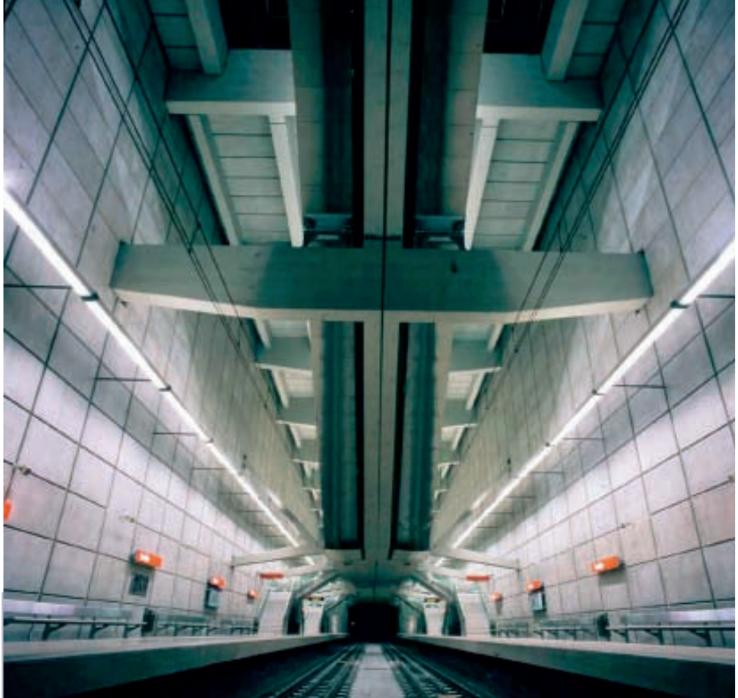
Estación de Sarriko del Metro de Bilbao, proyecto en el que Sener trabajó en colaboración con el arquitecto británico Norman Foster, Premio Brunel 1998
